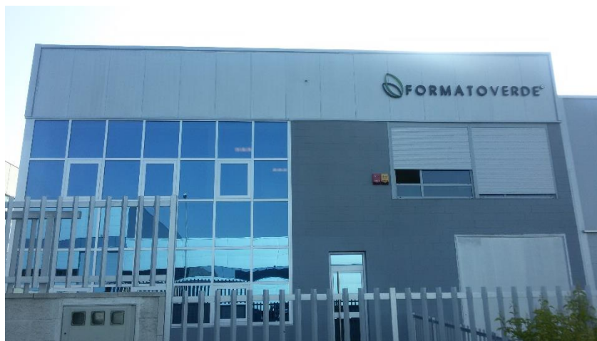
Exterior de las instalaciones de Formato Verde, S.L. en el Parque Empresarial de Pereiro de Aguiar.
